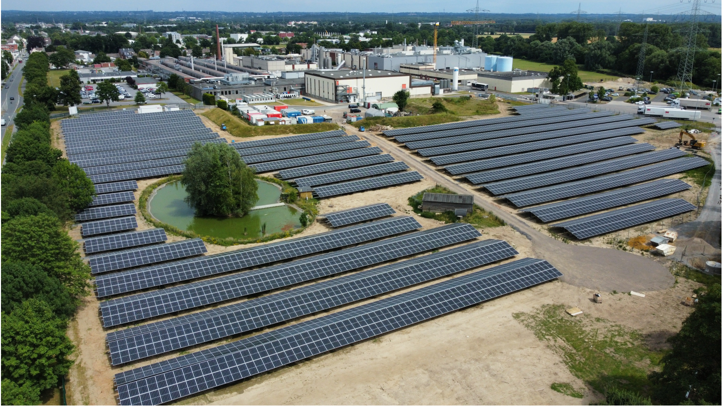
Die Emissionsreduktionsziele von 3M werden von der Science Based Targets initiative (SBTi) anerkannt, 3M Deutschland trägt unter anderem mit selbst erzeugtem Solarstrom dazu bei.
